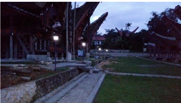
Gambar 11. Penerangan di Tongkonan Karuaya menggunakan PLTS
