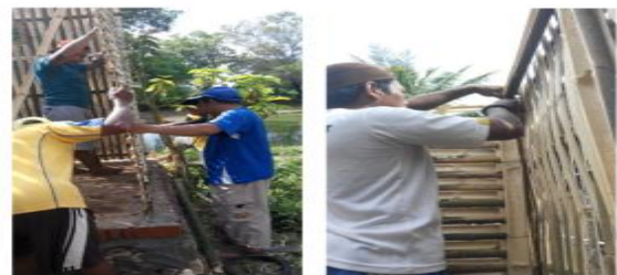
Gambar 5. Pembuatan pondasi dan Pemasangan bambu plester
