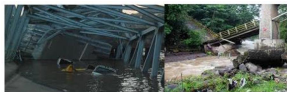
Gambar 1. Peristiwa robohnya struktur jembatan sebelum usia rencana
