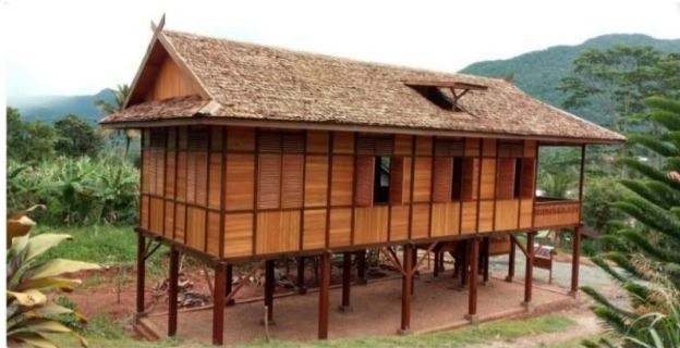
Gambar 11 Fasad Bangunan Sumber : Analisis Penulis,2022
